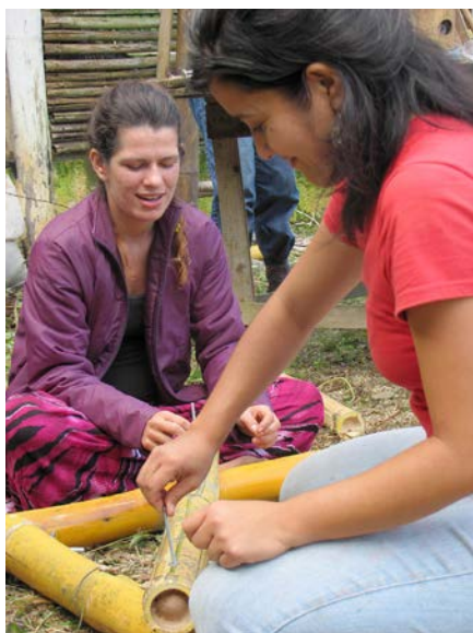
Construção do pergolado de bambu e do telhado vivo
